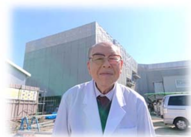
新棟建築現場にて
